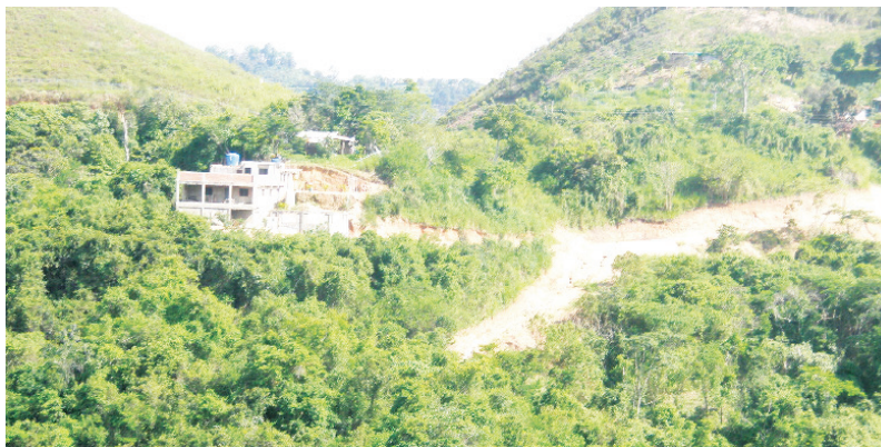
Daño causado por una vía de penetración • FOTOS CORTESÍA DE F BRACHO
